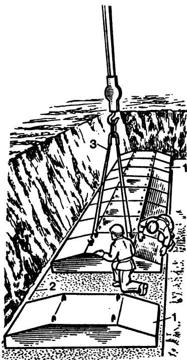
Рис. 110. Монтаж фундаментных плит: 1 — маячные плиты, 2 — причалка, 3 — четырехветвевой строп
